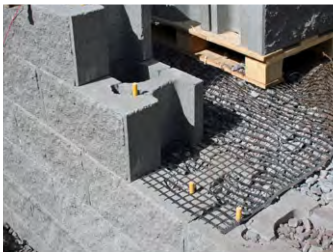
Keystone Compac med geonät.
