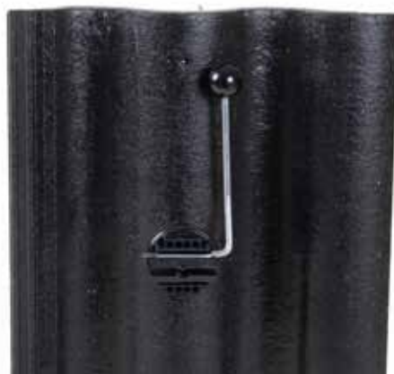
Bild 5. Demontage av Montageskena.
